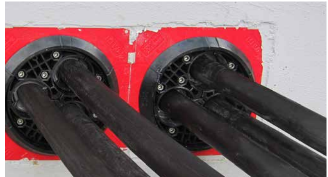
Verschiedene Montageschritte bei HSI150 DG 3x24-54
