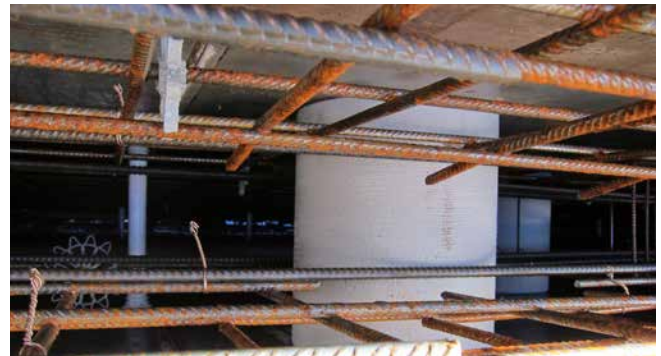
ZVR200/300 in der Schalung fixiert
