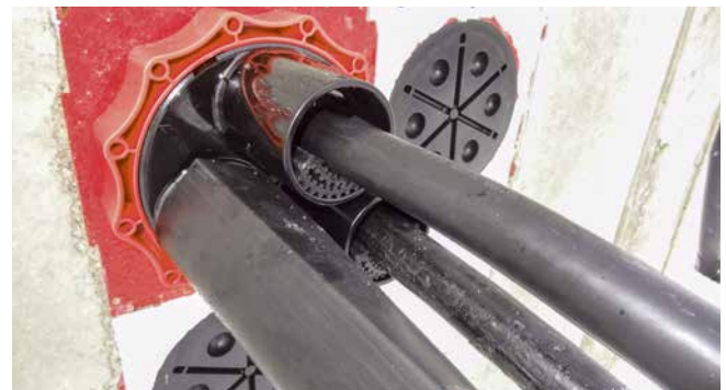
Zentrierband im Systemdeckelstutzen des HSI150 D3x58 WS
