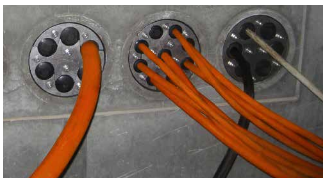
HRD150 SG eingebaut in Faserzementfutterrohre
