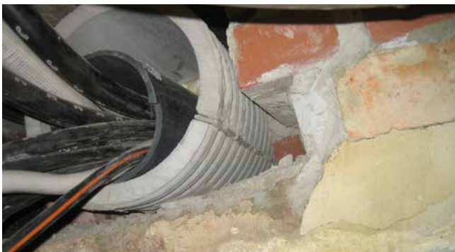
FZR100 / 240 Abdichtung Rohrtrasse
