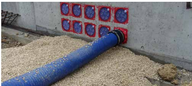
Anschluss des Kabeleinführungssystems KES MA150 D
