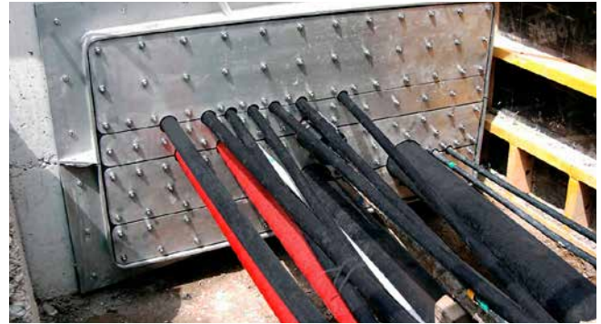
Geteilter Rechteck-Flansch mit Mehrfachbelegung
