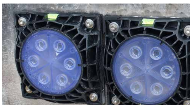
HSI150 DFK mit transparentem Deckel
