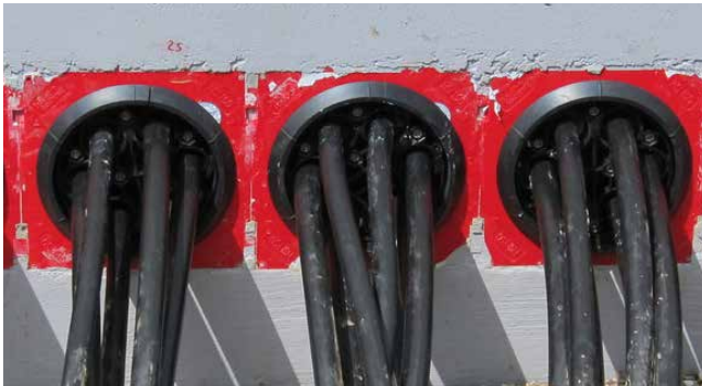
Abdichtung von Niederspannungskabeln mit HSI150 DG 6x10-36
