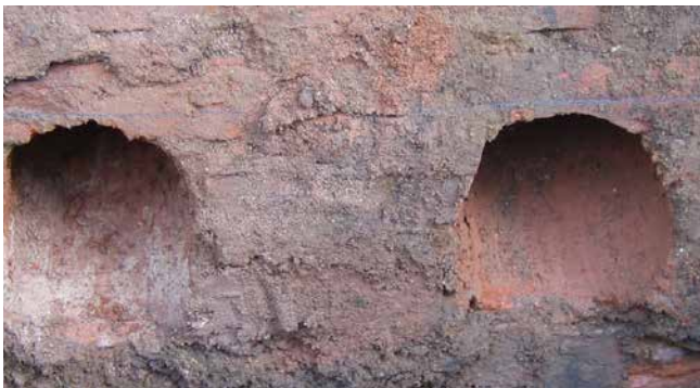
Schräge Kernbohrung in porösem Mauerwerk
