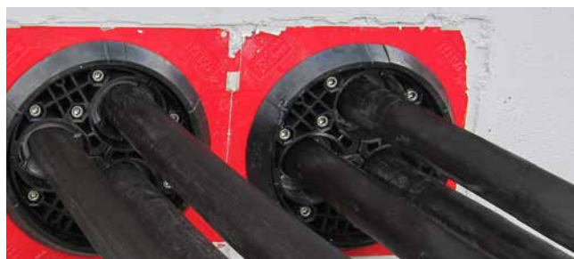
Abdichtung mit Systemdeckel HSI150 DG
