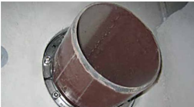
HSD200 1x160 b40 A2/EPDM55 Entwässerung SML Rohr
