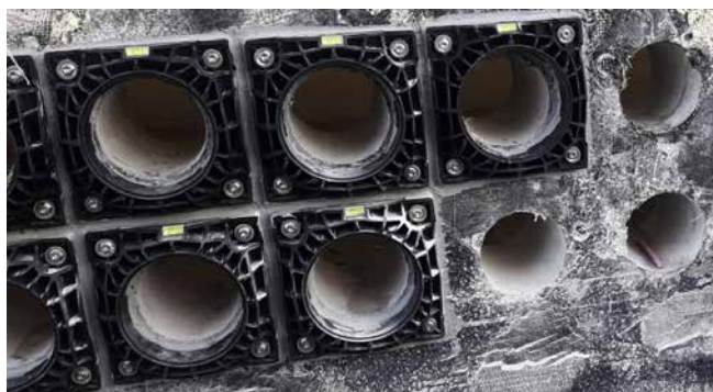
HSI150 DFK Kunststoffflansch
