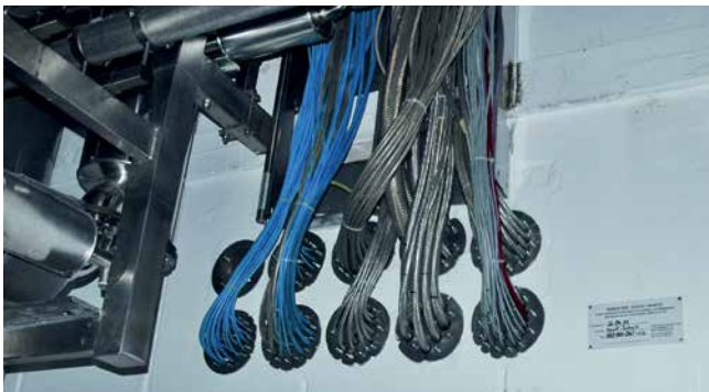
HRD150 G b30 mit Mehrfachbelegung
