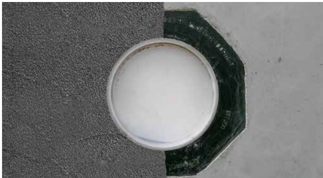
Betoniertes UFR mit PMBC
