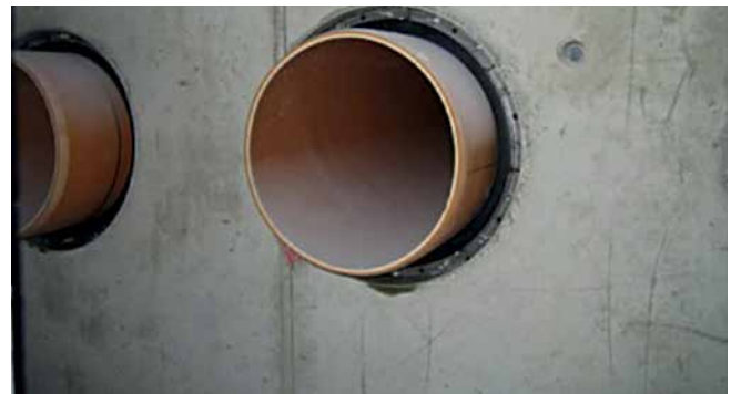
HSD500 G 1x429 b40 A2/EPDM55 Be-/Entlüftung
