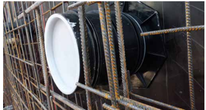
UFR in Schalung
