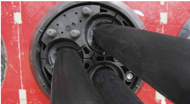
Pressplattenabdeckung HSI150 DG PA 3x24-54
