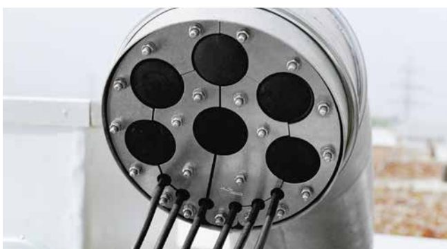
Montierter Dichteinsatz SKD in Schwanenhals SHD 200
