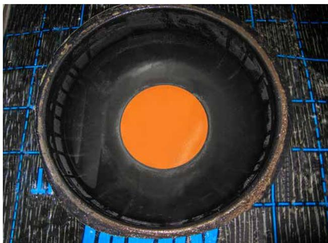
Einfache Einbindung der Dampfsperre über Klebeflansch
