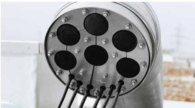
Montierter Dichteinsatz SKD in Schwanenhals SHD 200
