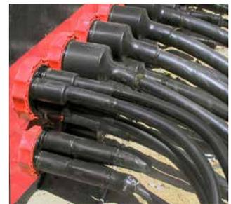
Stationseinführung: Niederspannungskabel abgedichtet mit HSI90 D1x75 WS und HSI90 D3x32 WS
