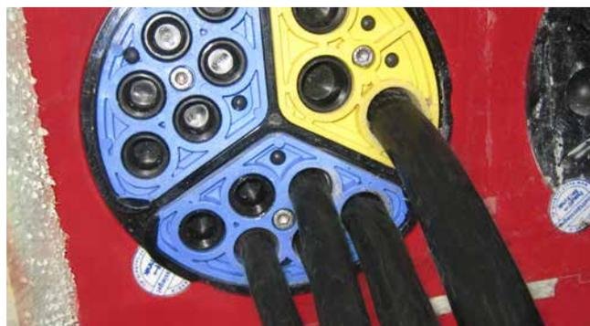
HSI150 SEGMENTO mit integrierter Drehmomentkontrolle und Blindstopfen
