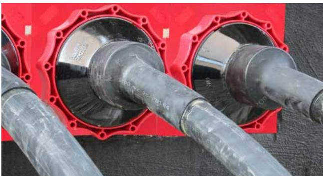
Stationseinführung: Niederspannungskabel abgedichtet mit HSI150 D1x80 WS
