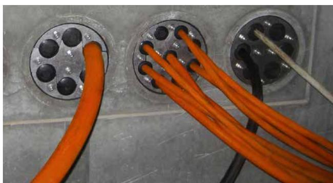
HRD150 SG eingebaut in Faserzementfutterrohre
