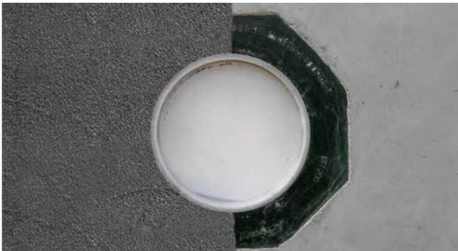
Betoniertes UFR mit PMBC
