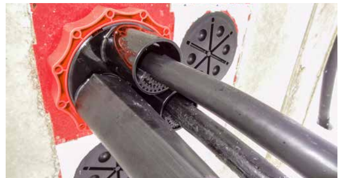
Zentrierband im Systemdeckelstutzen des HSI150 D3x58 WS
