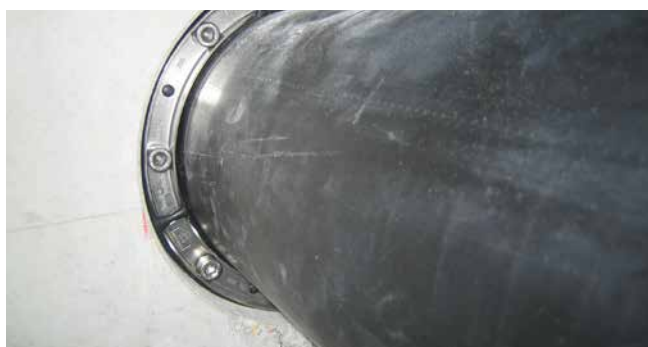
Detailansicht - HSD, Kontrollöffnung und Anzugsreihenfolge der Schrauben
