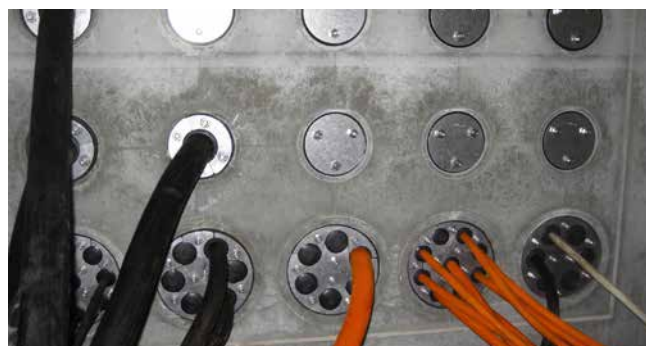
HRD150 SG eingebaut in Faserzementfutterrohre
