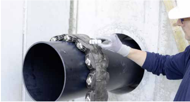
GKD400 - Montagevorbereitung mit Gleitmittel GM
