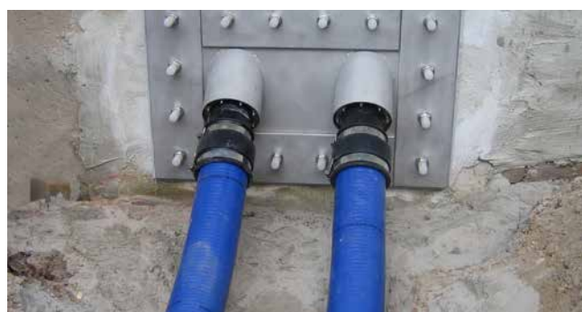
Eingebaute HSD b40
