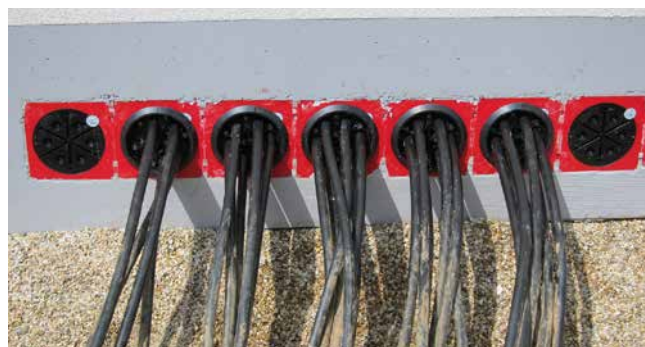
Abdichtung von Niederspannungskabeln mit HSI150 DG 6x10-36
