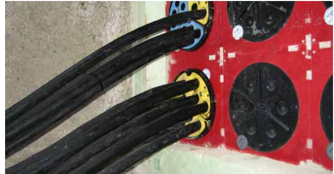
Abdichtung von Kabeln für Straßenbeleuchtung mit SEGMENTO
