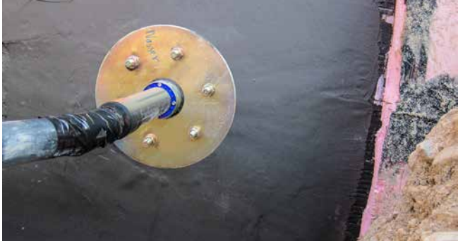
FLFE 1x200/X A3C mit der Standard-Ringraumdichtung HSDC (pulverbeschichtet)
