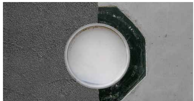
Betoniertes UFR mit PMBC
