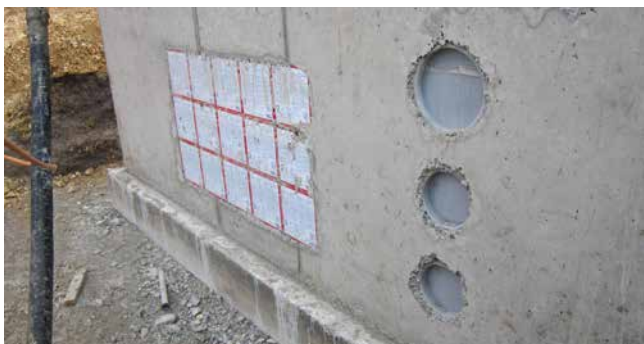
ZVR150 und ZVR200 einbetoniert neben HSI150
