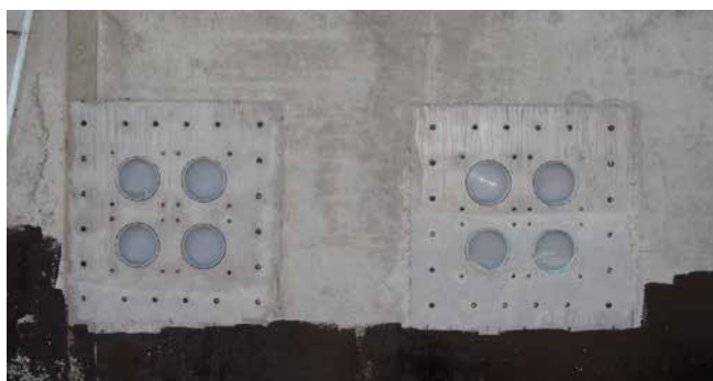
Festflansch der Doppel-Dichtpackung HSI150 2x2 FLFE/X einbetoniert
