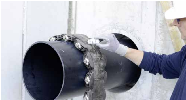
GKD400 - Montagevorbereitung mit Gleitmittel GM
