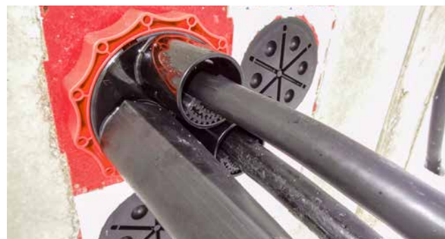
Zentrierband im Systemdeckelstutzen des HSI150 D3x58 WS
