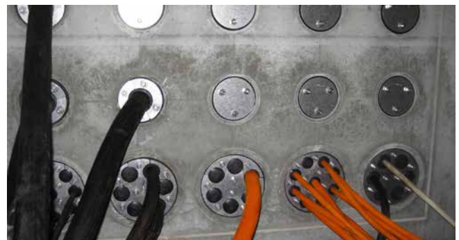
HRD150 SG eingebaut in Faserzementfutterrohre
