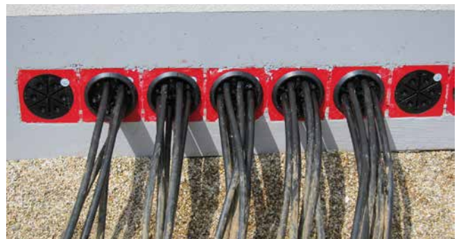
Abdichtung von Niederspannungskabeln mit HSI150 DG 6x10-36
