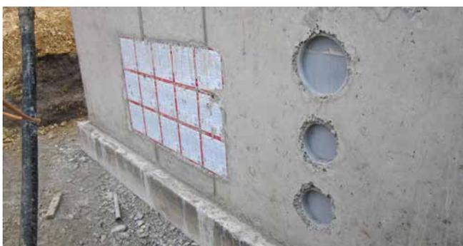
ZVR150 und ZVR200 einbetoniert neben HSI150
