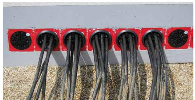
Abdichtung von Niederspannungskabeln mit HSI150 DG 6x10-36
