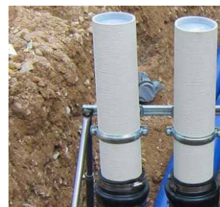
Disposition en rangées de 2x KES MA150 ZVR150/500 sur le dispositif d'installation KES FUBO-FIX AV
