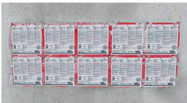
Passage double face HSI150 utilisé en paquet
