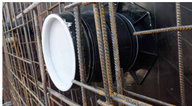
UFR dans le coffrage
