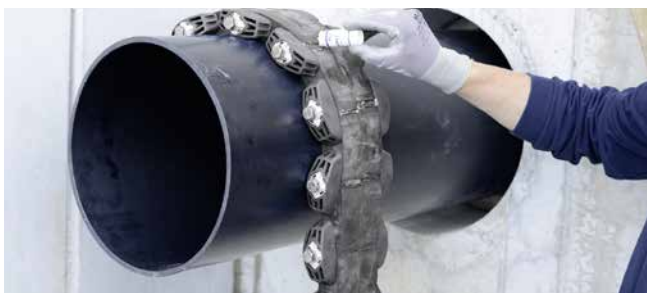
GKD400 – Préparation de l'installation avec lubrifiant GM
