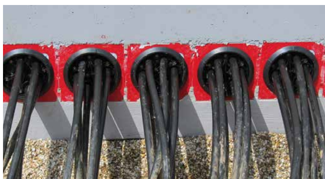
Étanchéité de câbles basse tension avec HSI150 DG 6x10-36
