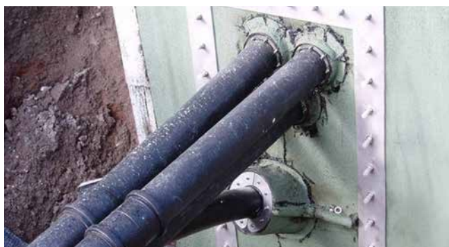
flasque fixe/amovible divisée conforme à DIN 18533
