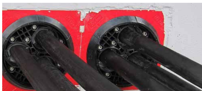
Étanchéité garantie avec couvercle HSI150 DG
