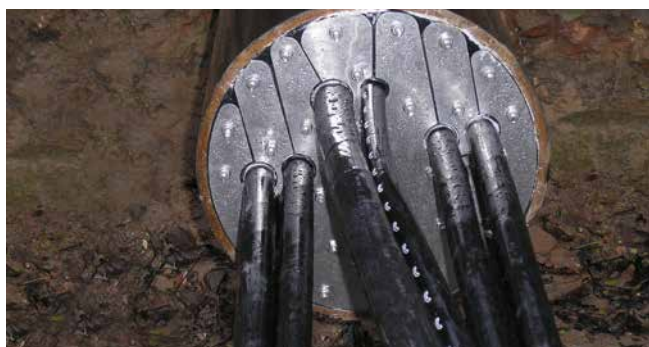
HRD200 G b30 dans un tube en acier
