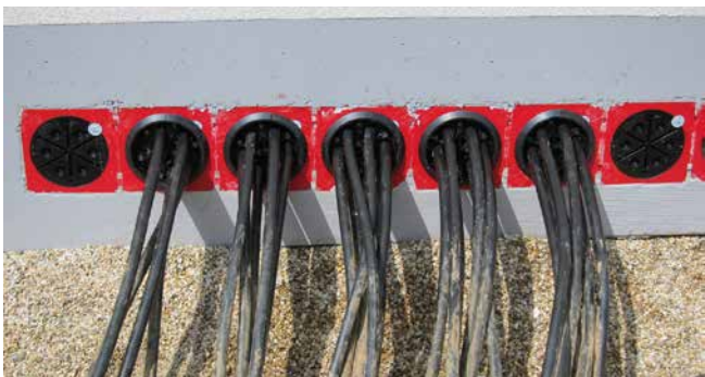
étanchéification de câbles basse tension avec HSI150 DG 6x10-36
