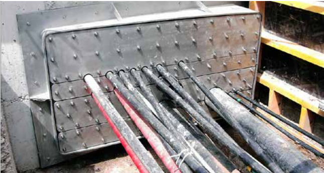
Flasque rectangulaire en deux parties avec occupation multiple
