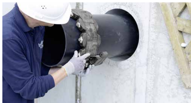
GKD400 - installation des segments
