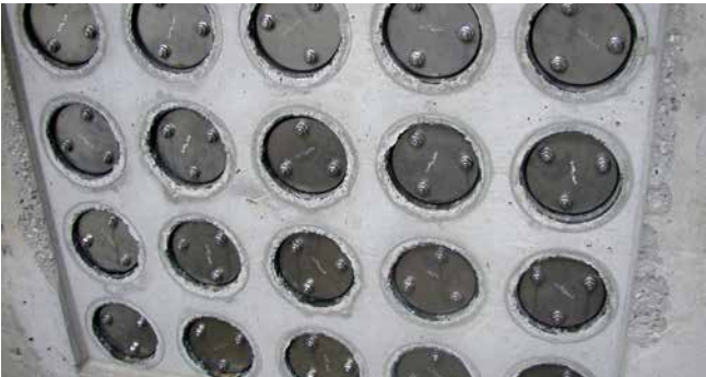
FZR100/240 - étanchement en batterie de réservations
