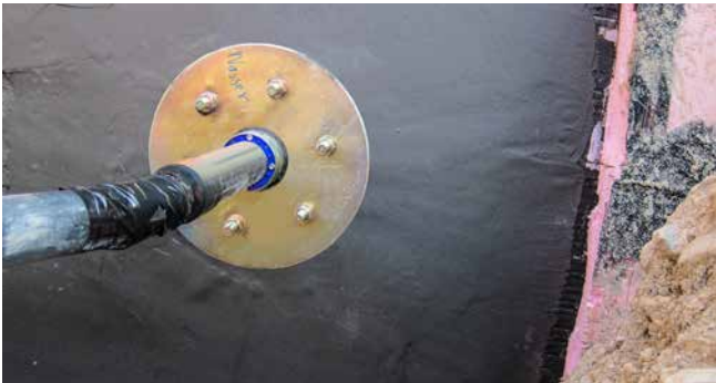
FLFE 1x300/X A3C avec joint annulaire standard HSDC (revêtu par poudre)
