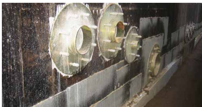
D1: Gaine Øi, D2: Bride fixe Ø, D3: Bride amovible Ø
