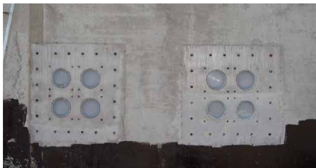
Flasque fixe à sceller dans le béton pour passage étanche double face HSI150 2x2 FLFE/X
