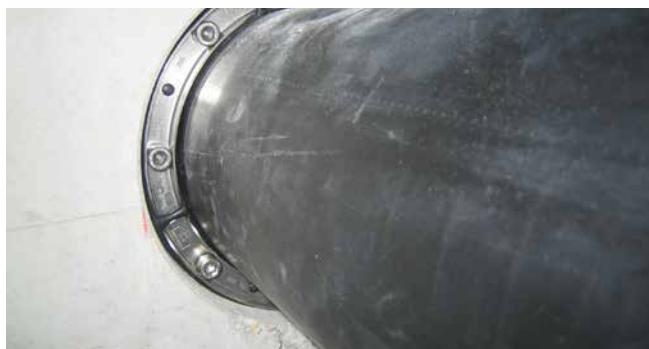
Vue détaillée - HSD, ouverture de contrôle et ordre de serrage des vis
