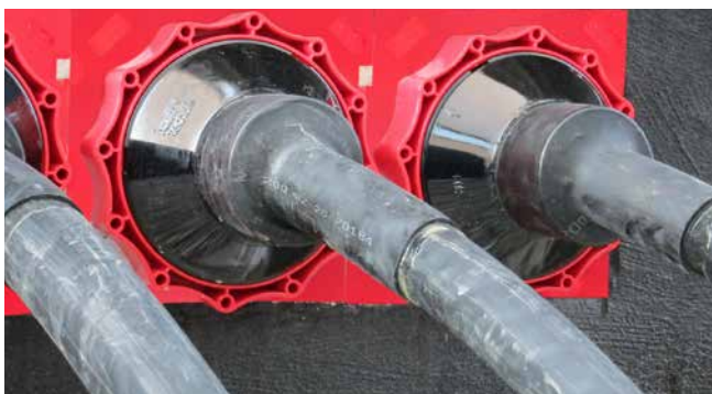
Entrata stazione: cavo di bassa tensione sigillato con HSI150 D1x80 WS
