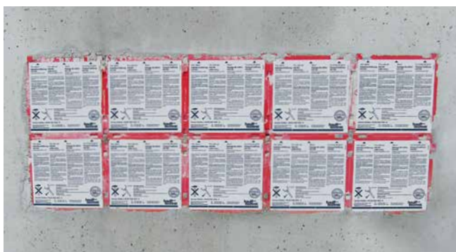
Passaggio impermeabile doppio HSI150 in forma di pacchetto
