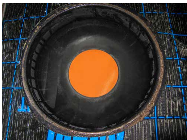
Facile integrazione della barriera al vapore mediante la flangia adesiva
