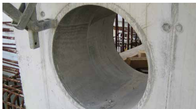
FZR400/300 Impianto di depurazione nel sito di installazione
