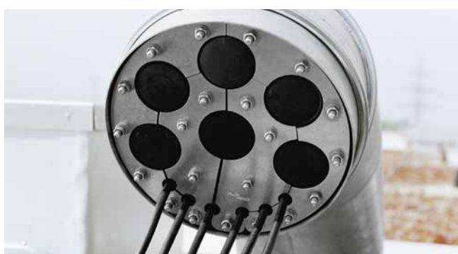
Inserto di tenuta SKD montato nel collo di cigno SHD 200
