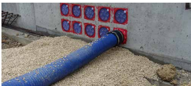
Collegamento del sistema di passacavi KES MA150 D
