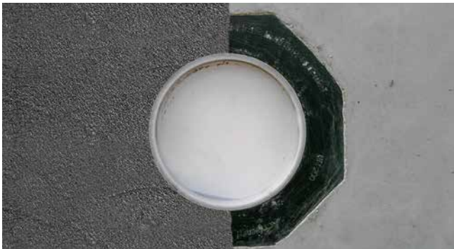
UFR sigillato nel calcestruzzo con PMBC
