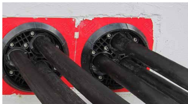
Varie fasi di montaggio con HSI150 DG 3x24-54
