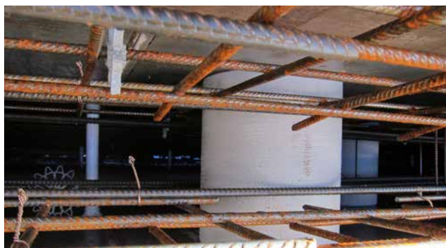
ZVR200/300 fissato nella cassaforma
