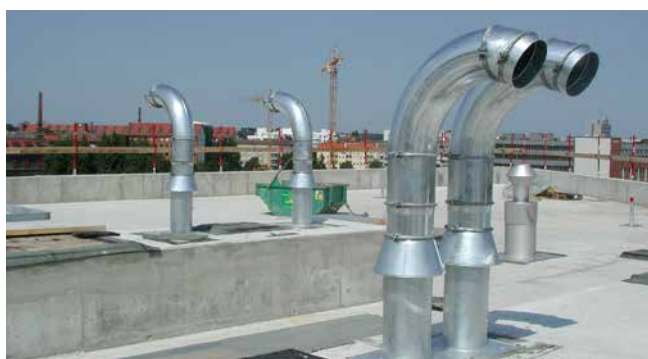
SHD200 montata prima dell'installazione della guarnizione del tetto
