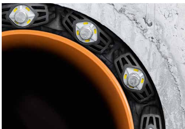
GKD già montato: tutte le finestre di ispezione sono completamente riempite di giallo.
