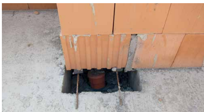
Difficoltà: sigillatura successiva a tenuta di gas e vapore
