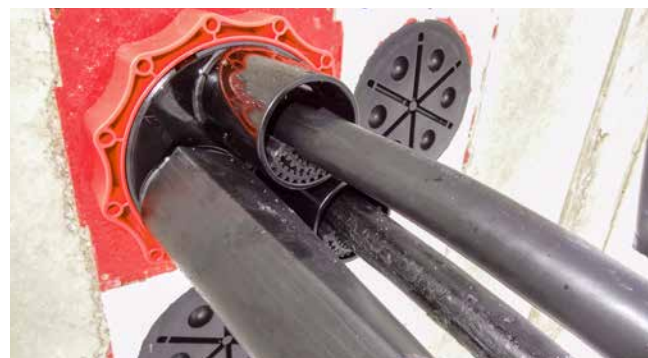
Nastro di centraggio nel bocchettone della copertura di sistema dell'HSI150 D3x58 WS
