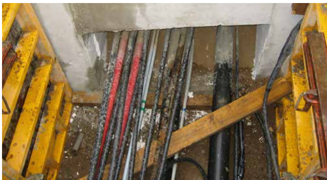
Cavità quadrata fornita in loco – Deve essere sigillata successivamente
