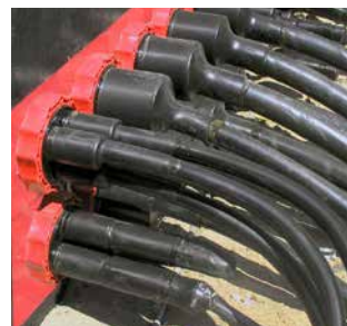
Entrata stazione: cavo di bassa tensione sigillato con HSI90 D1x75 WS e HSI90 D3x32 WS
