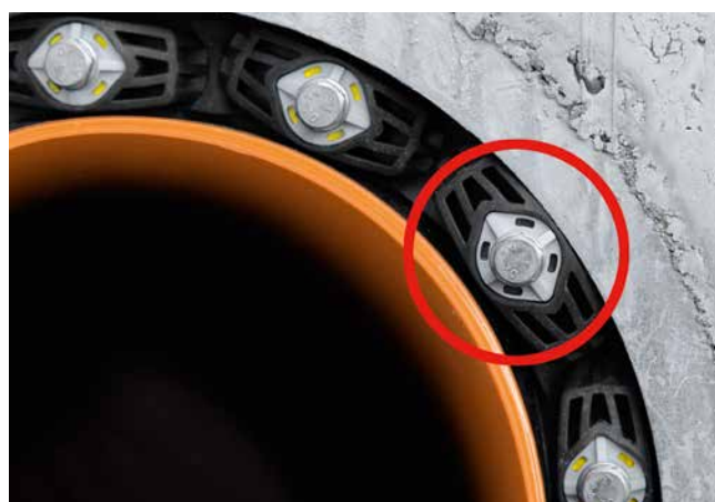
GKD con un segmento non serrato: errore di montaggio rilevato immediatamente.
