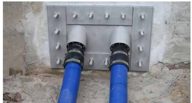
Flangia fissa/estraibile con collegamento obliquo al tubo vuoto a monte della sigillatura superficiale
