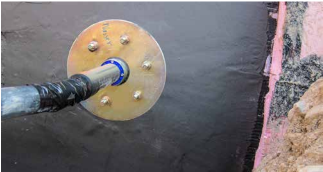
FLFE 1x200/X A3C con guarnizione standard HSDC (verniciata a polvere)
