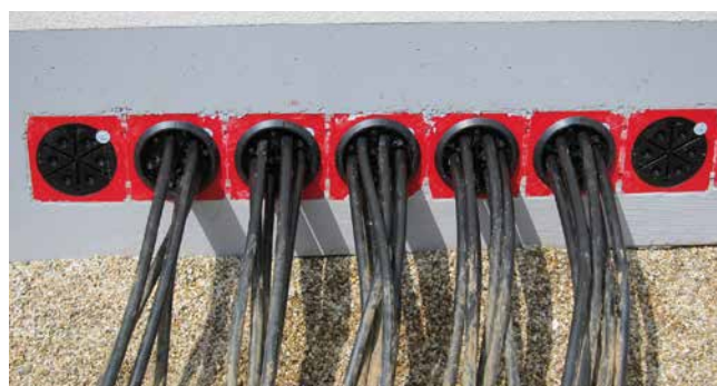
Sigillatura di cavi a bassa tensione con HSI150 DG 6x10-36
