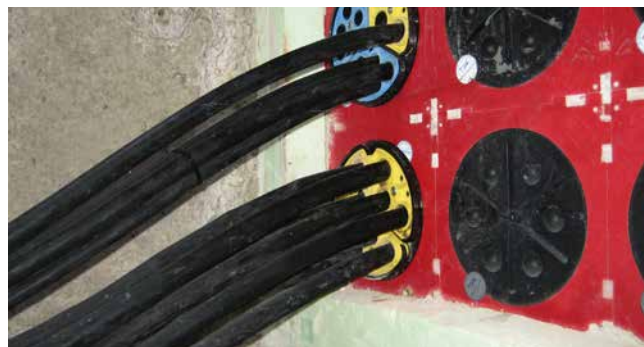
Sigillatura di cavi per illuminazione stradale con SEGMENTO
