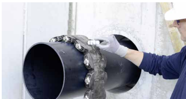
GKD400 - Preparazione all'installazione con lubrificante GM
