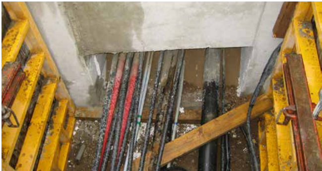
Scomparto rettangolare preesistente sul lato della costruzione - deve essere sigillato in un secondo momento
