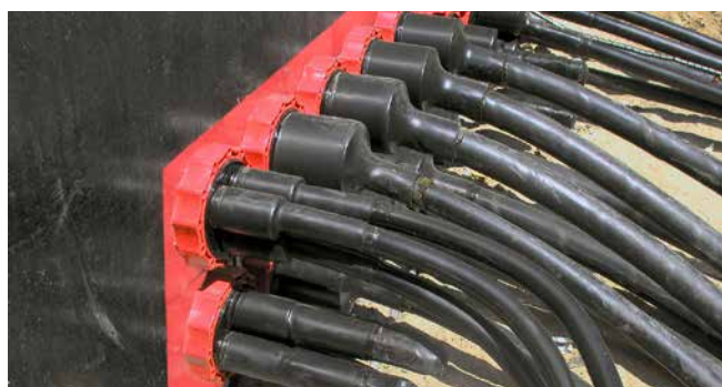
Ingresso stazione: cavo a bassa tensione sigillato con HSI90 D1x75 WS e HSI90 D3x32 WS
