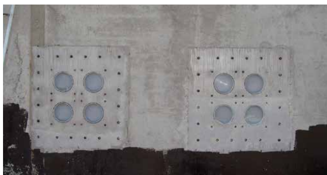
Flangia fissa della guarnizione doppia HSI150 2x2 FLFE/X incassata
