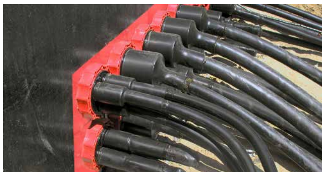
Ingresso stazione: cavo a bassa tensione sigillato con HSI90 D1x75 WS e HSI90 D3x32 WS
