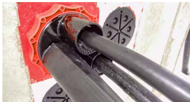
Banda di centraggio nel raccordo del coperchio del sistema HSI150 D3x58 WS
