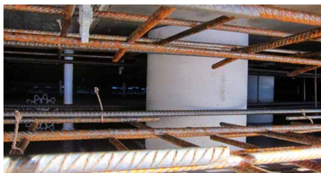
ZVR200/300 fissato nella cassaforma
