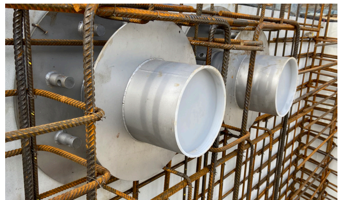
Der aufgeschweißte Mittelflansch dient als zusätzliche Wassersperre in der WU-Betonkonstruktion. Letzendlich erfolgt die Anbindung an die Bewehrung.
