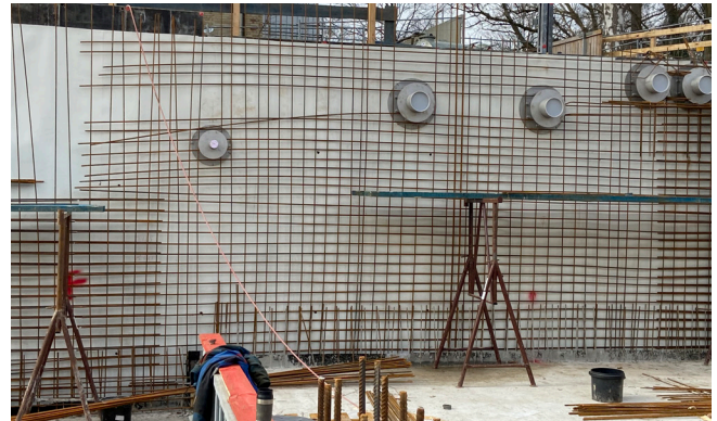
Die Flansche werden in die jeweilige Position gebracht.
