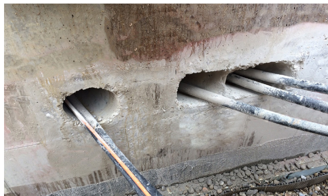
Bijzonderheid: de kabels lopen onder verschillende hoeken het mediakanaal in en uit. De positie van de kabels kan niet worden gewijzigd. Afbeelding: kabeluitgang uit het mediakanaal
