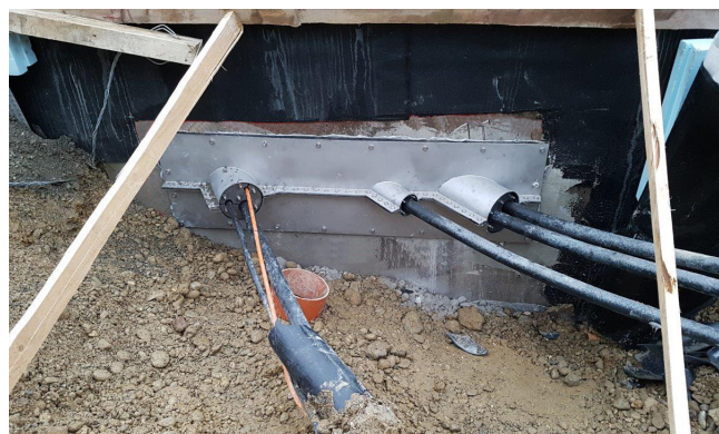
Afbeelding: kabeluitgang uit het mediakanaal
