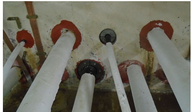
2 个密封件的试验安装
