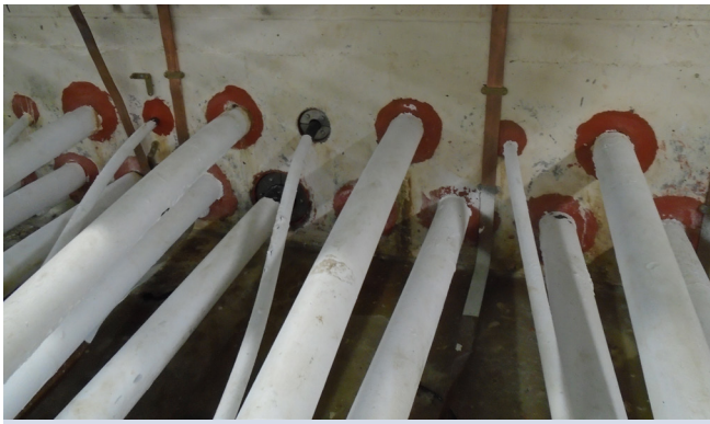
Wassereintrittsstelle mit Testmontage aus 2 Dichtungen
