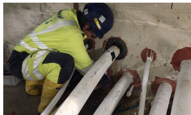
Ugradnja HRD 188-1G-1/97
