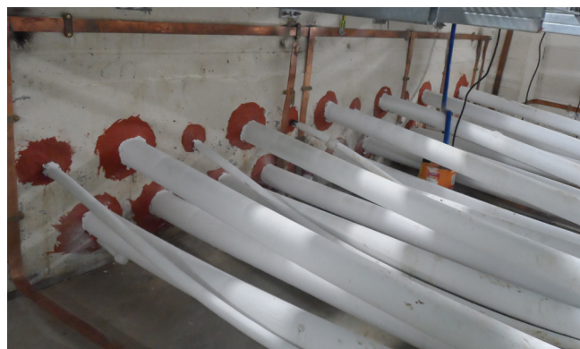
Szivárgó ragasztószeres tömítési megoldás
