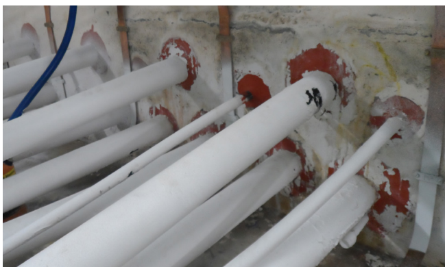
Szivárgó ragasztószeres tömítési megoldás
