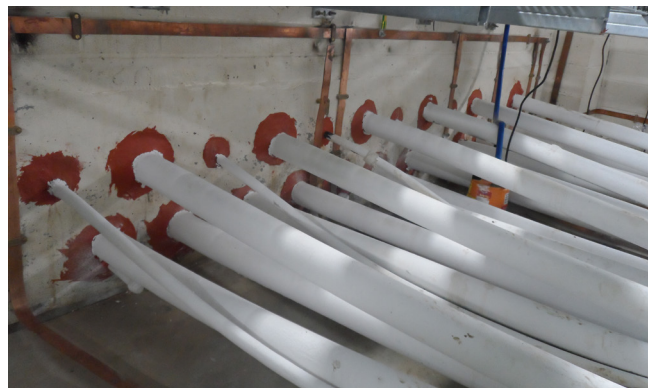
Läckagetätning med mastix
