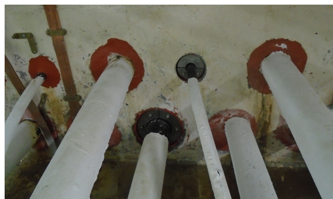
Testinstallation av två tätningar
