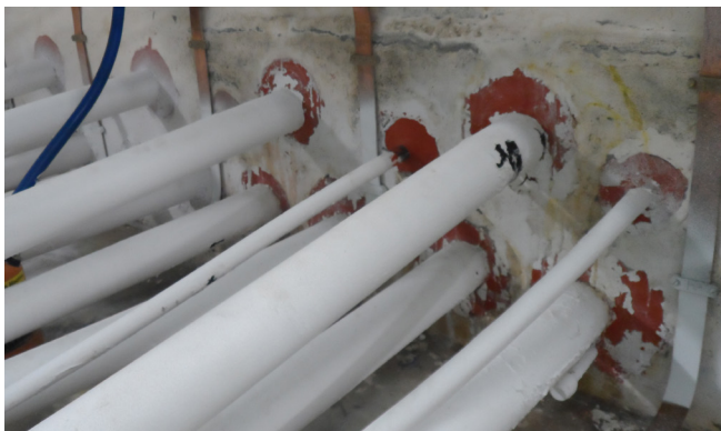
Läckagetätning med mastix
