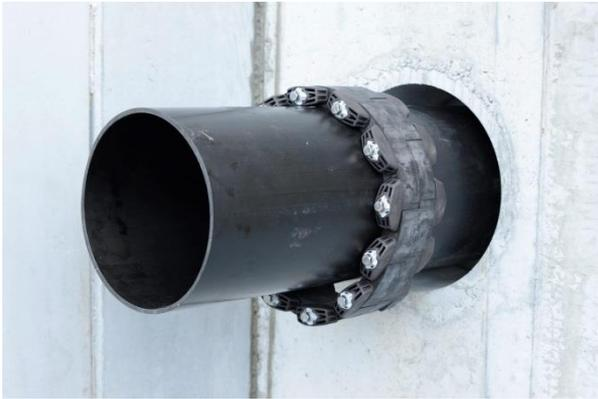
Das modulare System der Hauff-Gliederkette ermöglicht es mit nur 12 verschiedenen Segmentgrößen, durch die Variation der Kettenlänge Rohre mit Durchmesser 48,3 – 3.000 mm und Ringspalte zwischen 19,5 und 98 mm druckdicht abzudichten.
