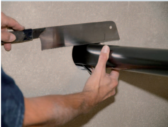
Bild 8 + 9: Wanddurchführungsrohr wird eingekürzt und Wandabschluss-Rosette aufgesteckt
