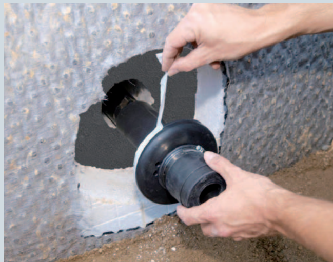
Bild 4: Hauseinführung mit Außenflansch und Butylband
