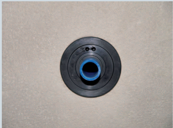
Bild 8 + 9: Wanddurchführungsrohr wird eingekürzt und Wandabschluss-Rosette aufgesteckt
