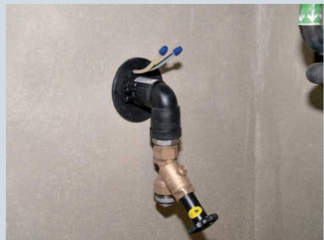
Bild 10 + 11: Wasserhausanschluss und Mitverlegung von Micropipes zur Vorbereitung einer späteren Glasfasererschließung
