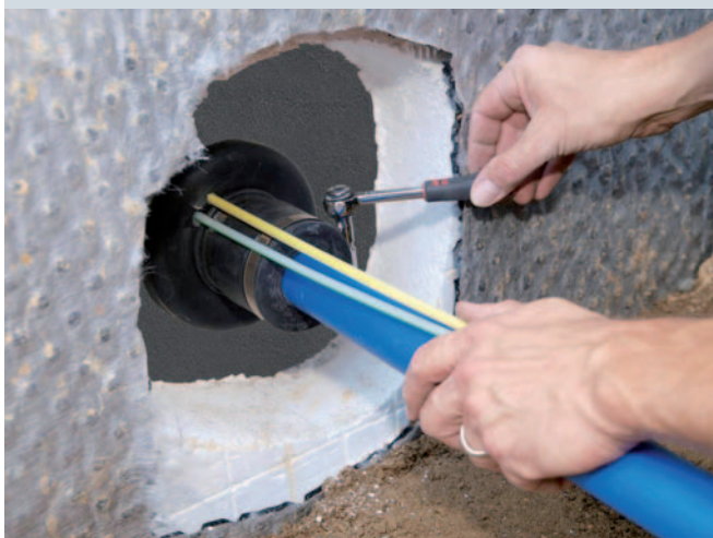
Bild 10 + 11: Wasserhausanschluss und Mitverlegung von Micropipes zur Vorbereitung einer späteren Glasfasererschließung
