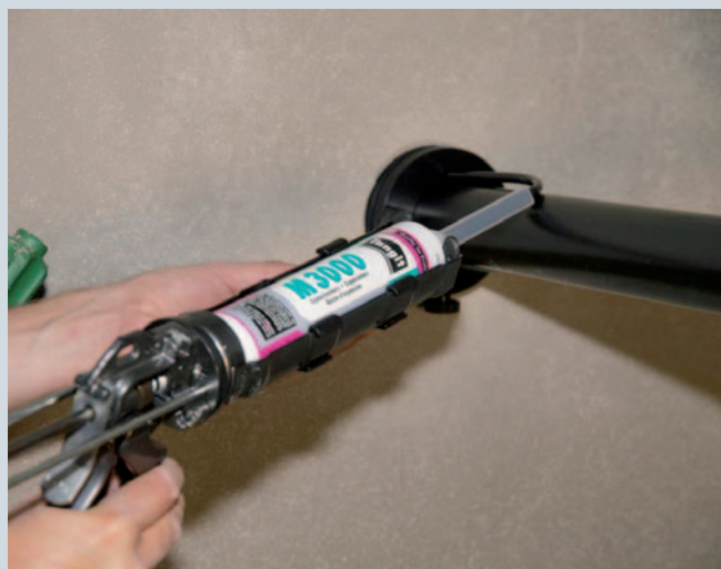
Bild 6: Expansionsharz Tangit M 3000 wird injiziert
