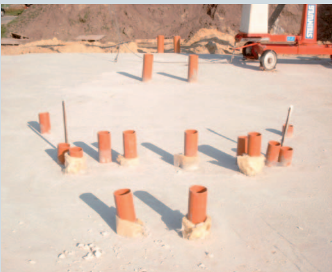
Bild 1: Hauseinführungen und Abdichtungen wie sie nicht sein sollten
