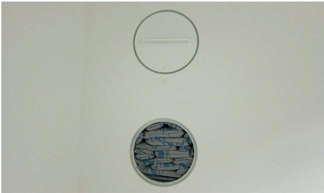
HVS Kabelschottung (Szenographie); oben: mit Verschlussdeckel
