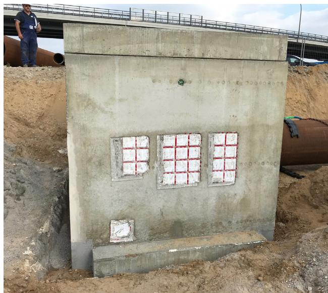
Auch im Außenbereich sind mehrere Kabelschächte mit bereits einbetonierten Kabeldurchführungen im Erdreich verbaut. Somit konnte ein dichtes Kabelleerrohrsystem zwischen den Brückenauflegern und dem elektrischen Betriebsgebäude initiiert werden.
