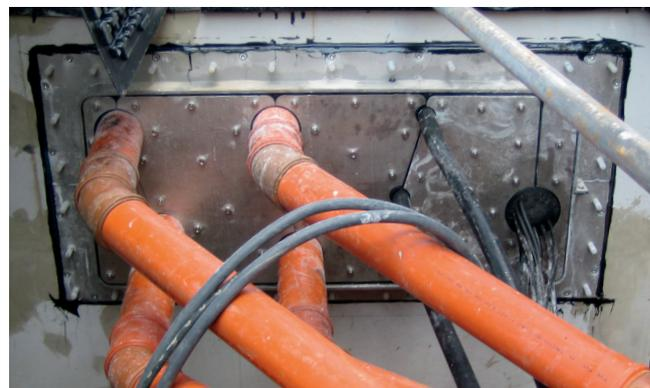
Kabelschutzrohre mit verlegten Kabeln – montierte Edelstahl-Flanschplatten vor dem Auffüllen des Grabens
