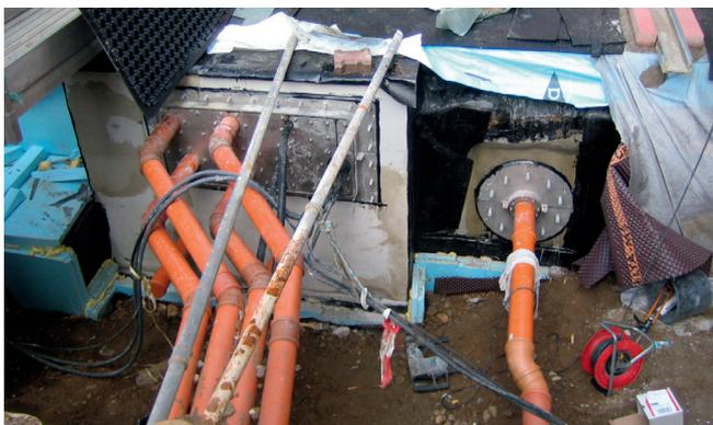
Kellerbereich – Montage der Fest-/Losflanschkonstruktion
