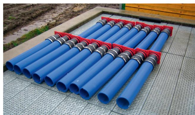
Materialkoordinierung – Verlegung vom Hateflex-Spiralschlauch 14150 mit Manschettentechnik. Die Systeme wurden im Vorfeld ausgelegt, um die Zuordnung in der Betonwanne sicher zu stellen.
