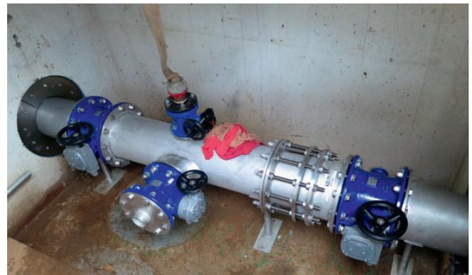
Ringraumdichtung HRD und Edelstahlflansch-T-Stück mit Absperrklappen und Entlüftungsventil
