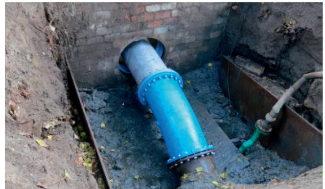
Baugrube mit Untergrundvorbereitung zur Vermeidung von Setzungen und betoniertem Stützsockel
