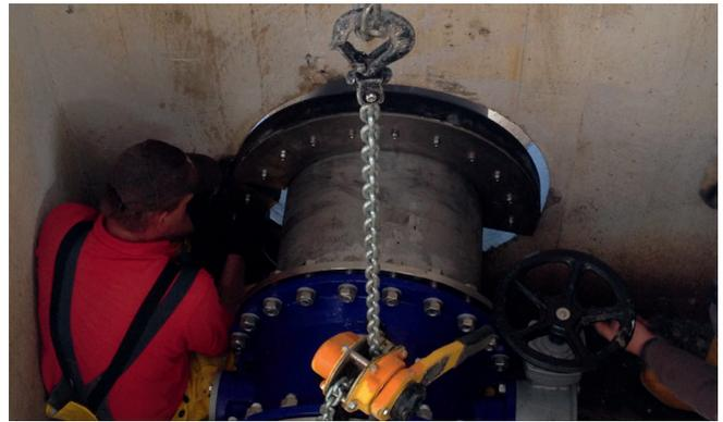
Montage der geteilten Ringraumdichtung HRD zur Abdichtung der Edelstahlleitung in Kernbohrung
