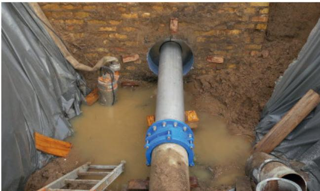
eingesetzte Ringraumdichtung HRD mit zentriertem Edelstahlrohr in der Kernbohrung
