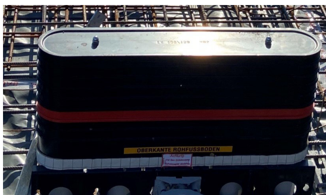
Le composant brut du point d'entrée multi-points dans le bâtiment, MSH Basic FUBO R5, est aligné sur le banquetage et préparé pour le bétonnage de la dalle de sol. Dans le cadre du projet de quartier de Neustadt, la quintuple entrée au sol est assurée par les sections suivantes : chauffage urbain aller et retour, eau potable, électricité et télécommunications.
