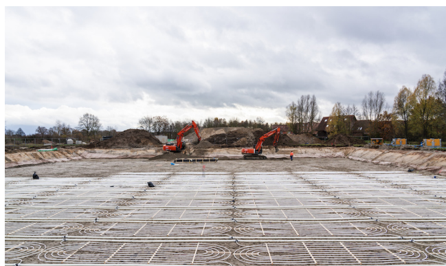
La surface de captage a été installée sous le chantier.
