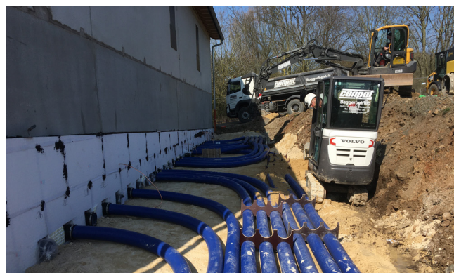
A bebetonozott HSI150 tömítőcsomagok gáz- és vízzáróak. A betonfalban található, az épületszigetelés mögött. A KES-M 150-D rendszerfedéllel csatlakozik a tömlő a tömítőcsomaghoz.
