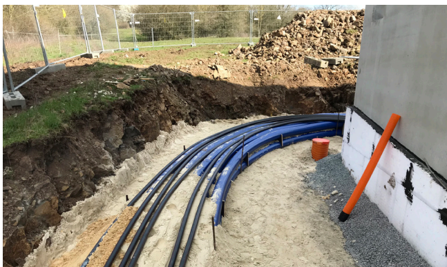
Exacte montage van Hateflex-spiraalslangen met de afstandhouders KES150-2x3 KA voor een optimale bodemcomprimering en latere kabellegging.
