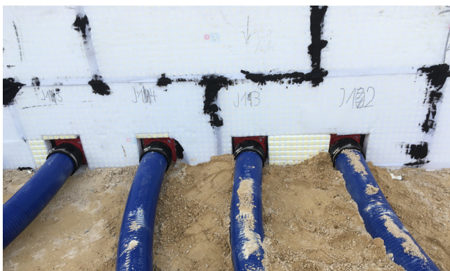
Met een rubbermanchettechniek wordt de spiraalslang Hateflex14150 gas- en waterdicht op de in beton gestorte kabeldoorgangen HSI150 aangesloten.
