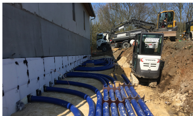
De in beton gestorte afdichtpakkingen HSI150 zijn gas- en waterdicht. Ze bevinden zich in de betonnen wand, achter de gebouwisolatie. Met de systeemdeksel KES-M 150-D wordt de slang op de dichtpakking aangesloten.
