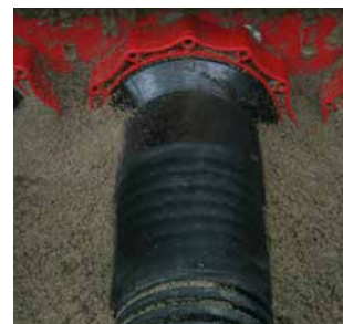
geribde mantelbuizen met koude HSI150 D1x110 KS WR
