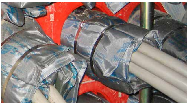
HSS – inbouw van brandbeveiligingskussens in instortpakking HSI150-K2, afdichting met systeemdeksel of Segmento
