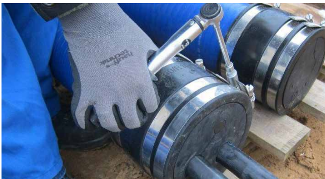
drukdichte aansluiting van de Hateflex-spiraalslang 14090 op de afdichtpakking HSI90 en de afsluitkap voor de mantelbuis
