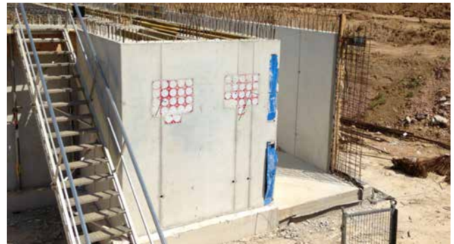
HSI90 na het inbetonneren: hier volgt de lege buisverbinding
