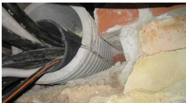
FZRG150/350 renovatie in het metselwerk
