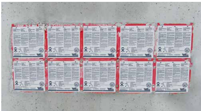
dubbele dichtpakking HSI150 als pakket in bekisting geplaatst
