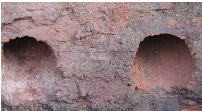
schuine boring in poreus metselwerk
