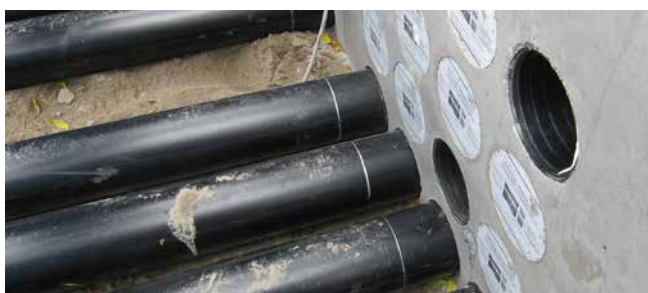
HSI150 GSM Varia als pakket geplaatst
