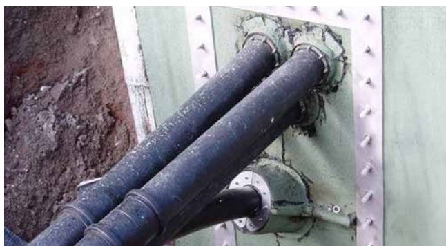
gesplitste vaste/losse flens op basis van DIN 18533
