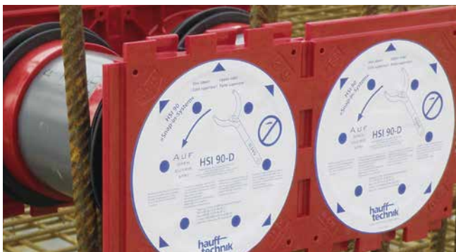
dubbele dichtpakking HSI90 als pakket in bekisting geplaatst
