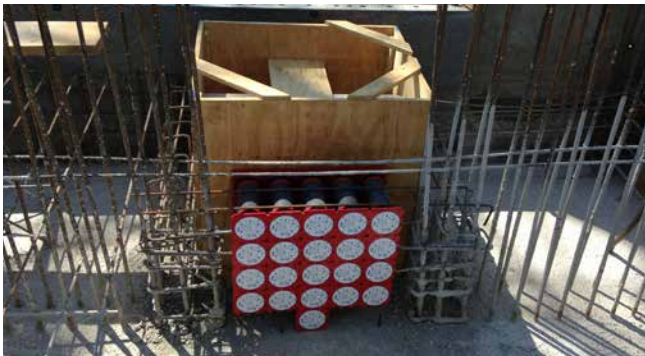
inbouw van dubbele instortpakking HSI90 in bekistingsnet voor het inbetonneren
