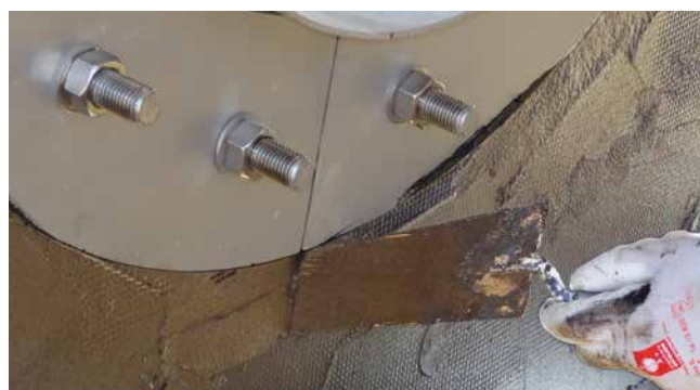
FLFE 1x300/X roestvrijstalen uitvoering met aansluiting op PMBC middels vliesaanvulling
