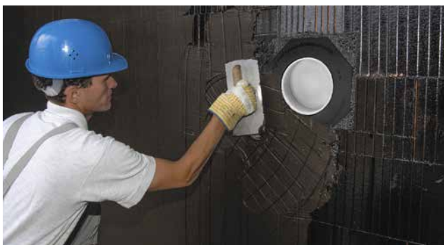
zabetonowany UFR z naniesioną powłoką hydroizolacyjną
