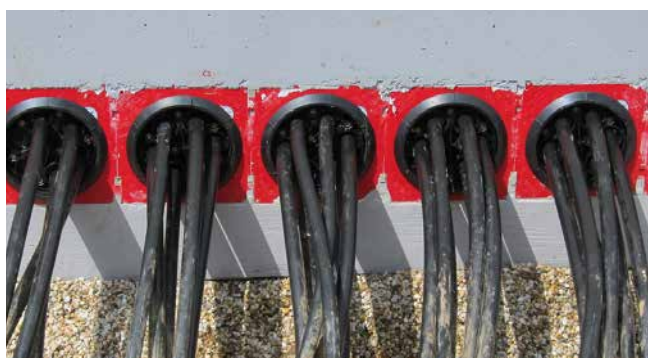
kable uszczelnione przy pomocy HSI150 DG 6x10-36
