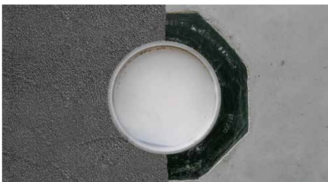
zabetonowany UFR z naniesioną powłoką hydroizolacyjną
