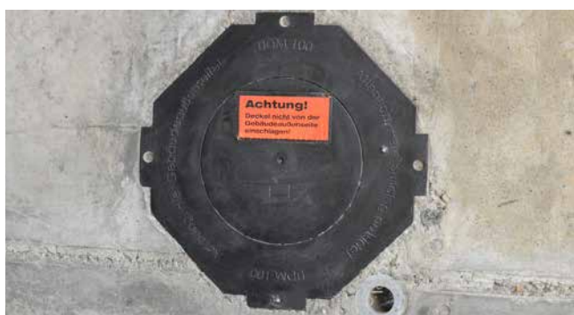
Duży czołowy kołnierz umożliwia połączenie z powłokami hydroizolacyjnymi obiektu
