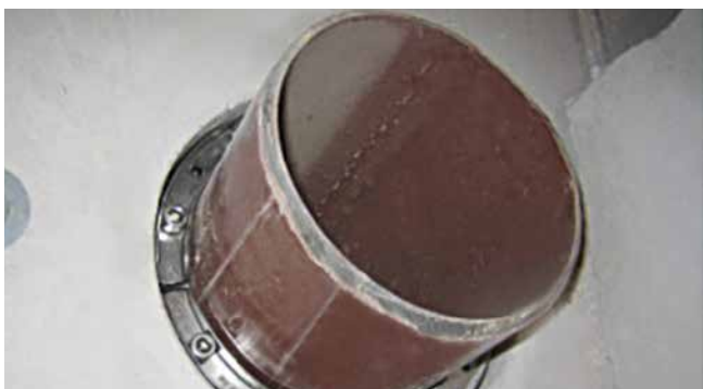
HSD200 1x160 b40 A2/EPDM55 instalacja odwodnienia deszczowego
