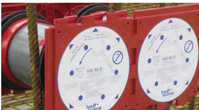
pakiet dwustronnych przepustów HSI90 zamocowany w szalunku
