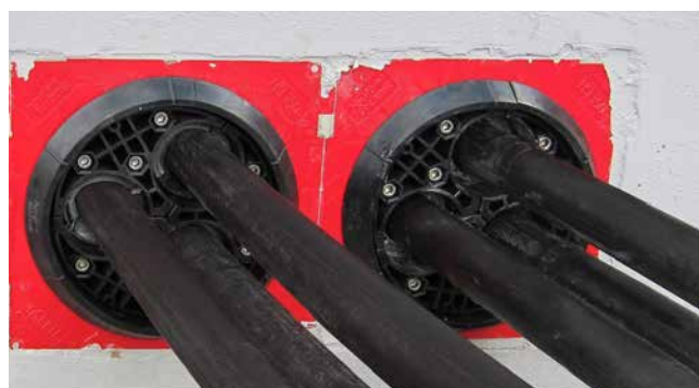
rożne fazy instalacji systemu HSI150 DG 3x24-54
