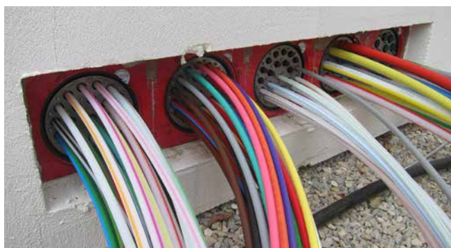
Zabetonowany przepust HSI 150 wraz z zainstalowanymi wkładami uszczelniającymi HRD 150 21x14 b60 A2/EPDM dla mikrorur.
