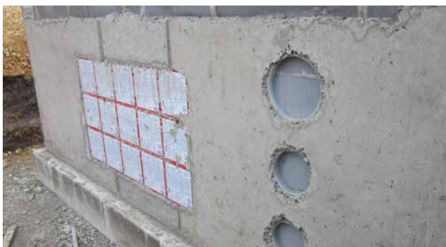
ZVR150 i ZVR200 zabetonowane obok przepustów HSI150
