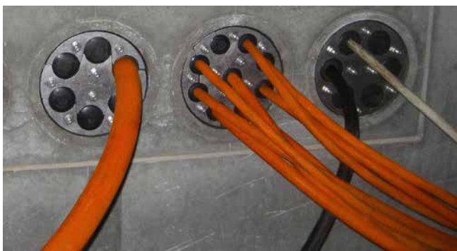
HRD150 SG – uszczelnione kable w odwiercie ściany betonowej
