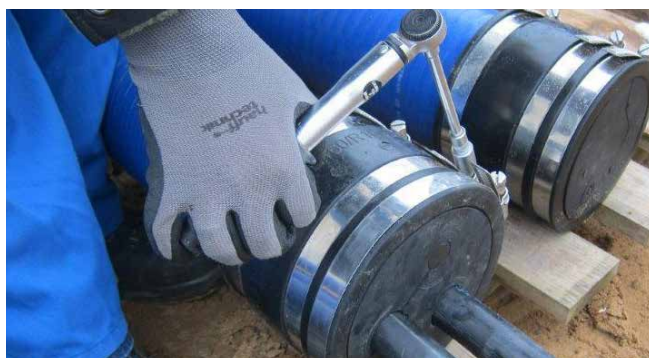
zastosowanie mankietów uszczelniających KES90 MA WE100 SG 1x18-65 SET wraz z systemem prowadzenia i ochrony kabli KES
