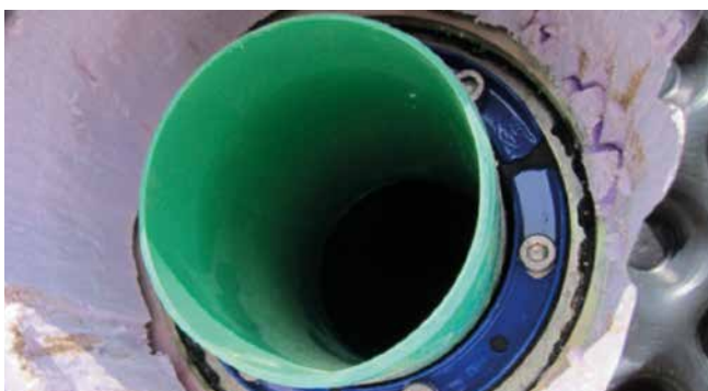
HSD-C 150/110 w ocynkowanym kołnierzu uszczelniająco-mocującym
