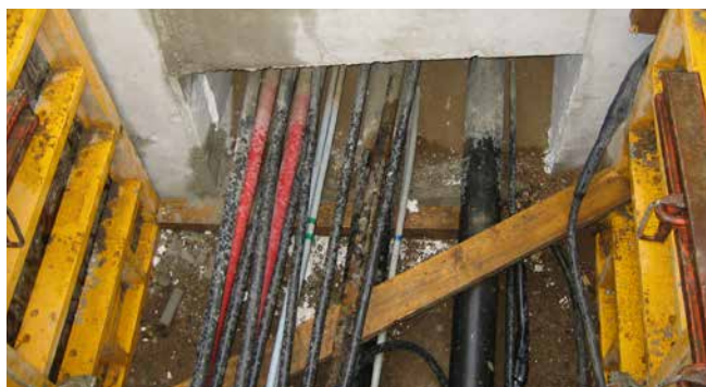
ukośne ułożenie rur i przewodów w otworze
