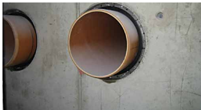
HSD500 G 1x429 b40 A2/EPDM55 napowietrzanie/odpowietrzanie
