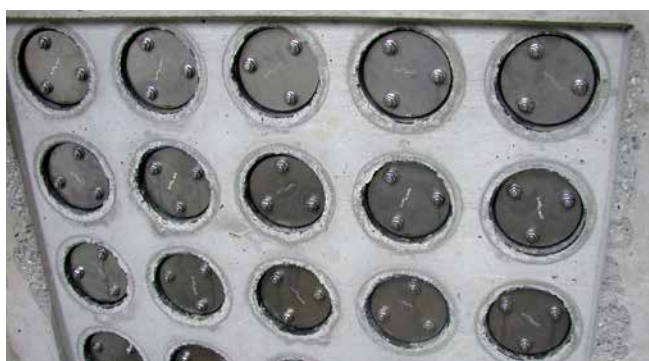
FZR100/240 po zabetonowaniu w oknie technologicznym, zaślepione gumowymi wkładami zaślepiającymi
