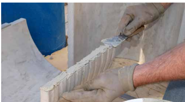
FZRG350/300 nanoszenie kleju epoksydowego MSET FZRG
