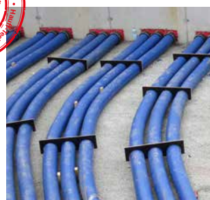
system prowadzenia i osłony kabli KES MA90 D z użyciem elastycznej rury osłonowej Hateflex
