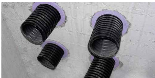
widok od wewnętrznej strony budynku, widoczne pierścienie centrujące
