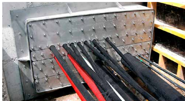
zastosowano flansze stalową z gumowym wkładem uszczelniającym w wykonaniu dzielonym
