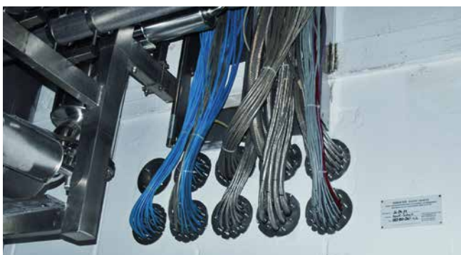
HRD150 G b30 uszczelnienie wielu kabli w odwiercie
