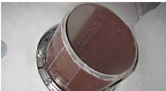
HSD200 1x160 b40 A2/EPDM55 instalacja odwodnienia deszczowego
