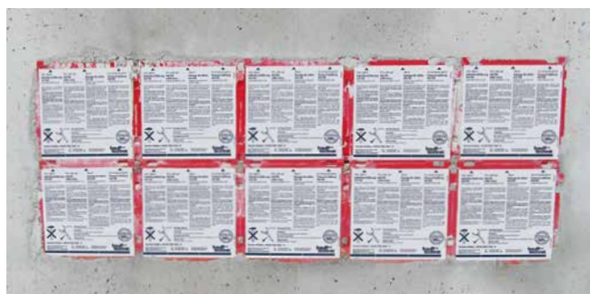
pakiet zabetonowanych przepustów HSI150 po rozszalowaniu
