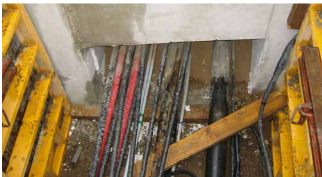
prostokątny istniejący otwór, uszczelnienie kabli już ułożonych
