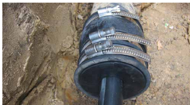
zestaw uszczelniający KES90 MA WE100 SG 1x18-65 SET do uszczelnienia kabli na końcu rury osłonowej
