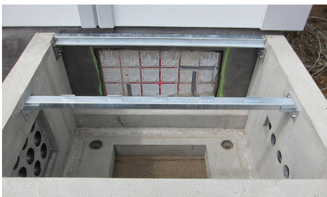
在大楼前的电缆引入装置区域还部分设置了电缆牵引和检查竖井。从而便于日后为增加的电缆铺设电缆引入装置。
