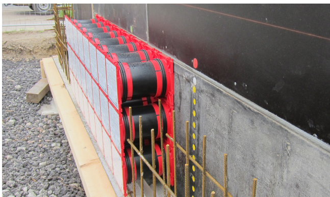
营业所大楼的不同侧面均安装了不同套装的电缆引入装置。通过套装组件得以实现连接例如电缆保护管的高铺装密度。
