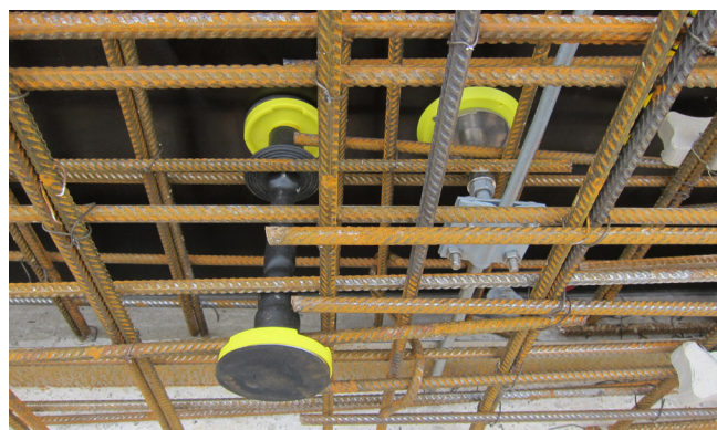
接地和电位补偿则采用多个接地引入装置和接地固定点。这些装置被安装在钢筋中并固定。接地固定点在浇筑混凝土之前已与电位补偿导线连接。
