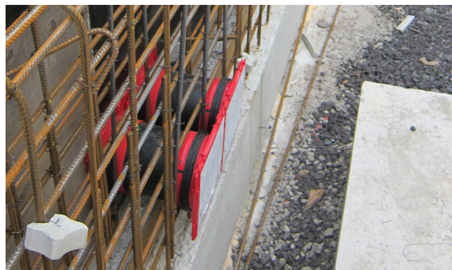
电缆引入装置被装入钢筋中并通过为连接而专门设计的孔固定在建筑模板内。
