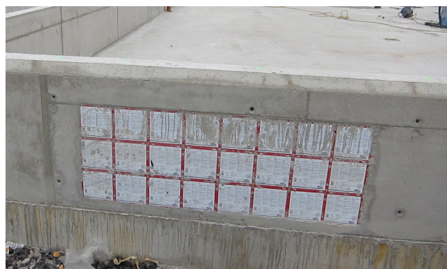
电缆地下室整体采用 WU 品质的混凝土进行浇筑。
