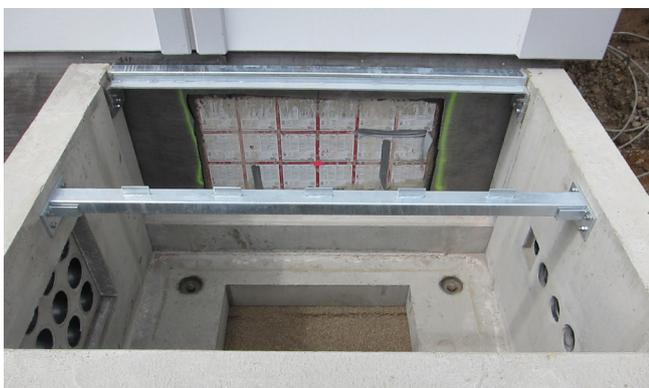
Des chambres de contrôle ou de tirage sont en partie réalisées devant le bâtiment, au niveau des passe-câbles. Elles facilitent un rééquipement ultérieur du passe-câbles avec des câbles supplémentaires.
