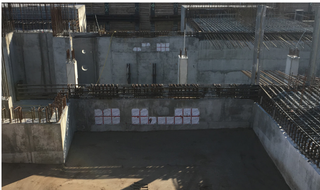
Se emplearon entradas de cable HSI150 K2 para la conexión de canales de cables, además de para el posterior sellado de cables.
