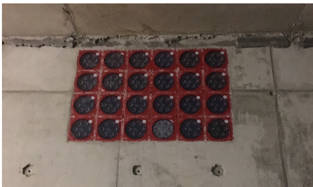
Las entradas de cable sin utilizar están selladas de forma permanente por medio de un sellado ciego a una presión de 2 bar. La cubierta de cerradura HSI150 DT transparente permite ver en todo momento si hay agua en la entrada del cable o en el conducto.
