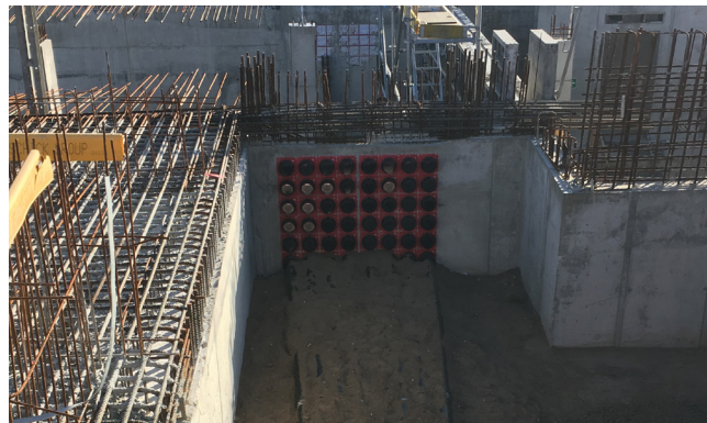
Los canales de cable lisos de 160 mm de diámetro se conectaron a la entrada del cable por capas mediante cubiertas de sistema HSI150 M168. La fotografía muestra la primera capa de canales de cables.
