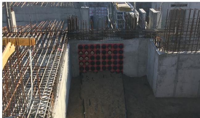
I tubi lisci di protezione dei cavi del diametro di 160 mm sono stati collegati a strati ai passacavi con tappi di sistema HSI150 M168. L'istantanea mostra il primo strato di tubi di protezione dei cavi.
