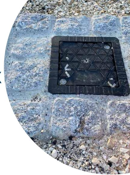
Der Einsatz der 2LINE G-BOX ermöglicht es, insbesondere bei „Homes Passed“-Anschlüssen, Glasfaser an einem definierten Übergabepunkt, zum Beispiel einem Kleinschacht, auf dem Kundengrundstück oder auch Gehweg abzulegen. In der 2LINE G-BOX, die auch nachträglich immer wieder zugänglich ist, wird die Glasfaser eingblasen und sicher abgelegt.
