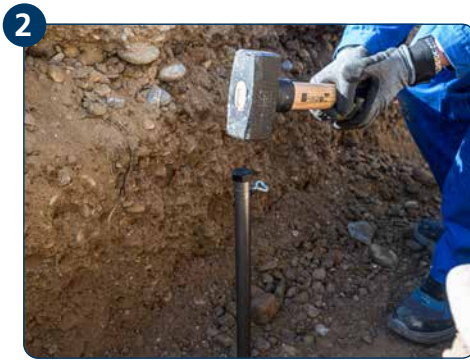
2 ETGAR Fundament-Box abnehmen und das Unterteil der Aufstellvorrichtung einschlagen.
