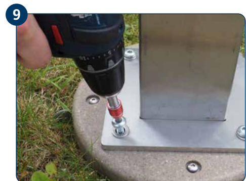
9 Endgeräte (Steckdosenleiste, Standleuchten) montieren.
