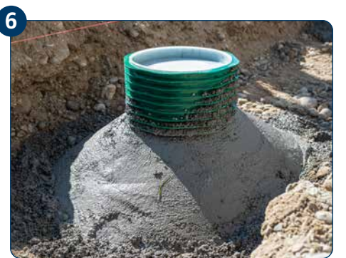
6 ETGAR Fundament-Box mit Magerbeton oder Estrichschnellzement fixieren.
