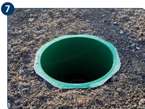
7 ETGAR Fundament-Box abschließend verfüllen.
