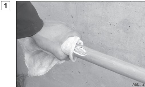
Im Bereich der aufzuschrumpfenden Manschette Kabelmantel mit lösungsmittelfreiem Kabelreiniger (KRMTX) reinigen und mit Schmirgelleinen aufrauen (siehe Abb.: 2).
