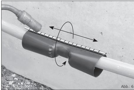
Um Lufteinschlüsse zu vermeiden, jeweils von der Mitte nach außen und rundum zu beiden Muffenenden hin gleichmäßig aufschumpfen, bis Kleber an beiden Enden austritt (siehe Abb.: Detail). Dabei im Bereich gegenüber der Verschlusschiene beginnen (siehe Abb.: 6).
