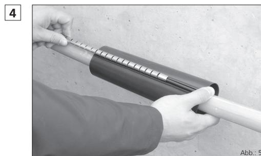
Verschlusschiene bündig aufschieben (siehe Abb.: 5).
