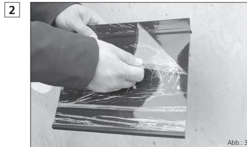
Schutzfolie von der Kleberfläche der Manschette abziehen (siehe Abb.: 3).
