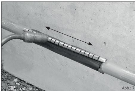
Sind beide Muffenenden auf diese Weise aufgeschumpft und die Manschette liegt gleichmäßig an, den Bereich der Verschlusschiene bzw. den überlappenden Manschettensektor auf der gesamten Länge nacherwärmen.
