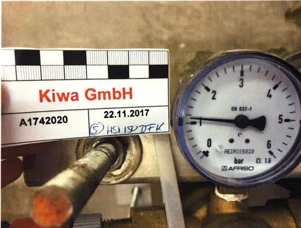
Abbildung A1. Druckdichtigkeitsprüfung der mit wassergefüllten Druckglocke bei einem Nenndruck von \geq 1 bar (Manometerstand bei Versuchsbeginn am 22.11.2017).
