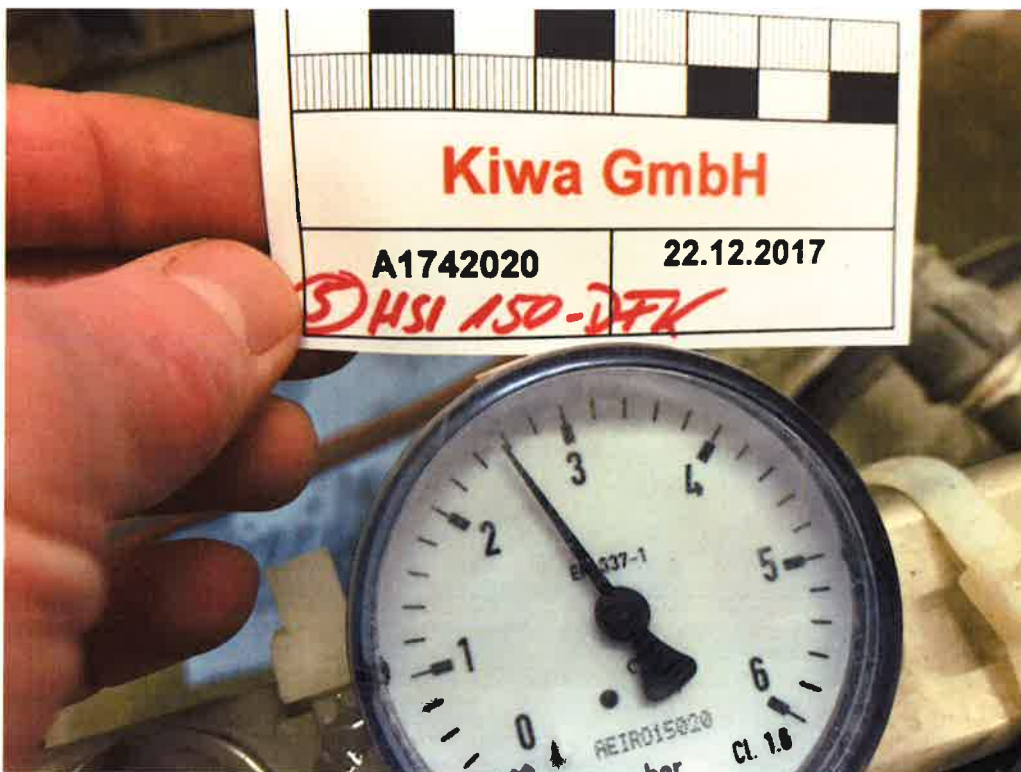
Abbildung A6. Druckdichtigkeitsprüfung der mit wassergefüllten Druckglocke bei einem Nenndruck von \geq 2,5 bar (Manometerstand nach > 24 Stunden am 22.12.2017).
