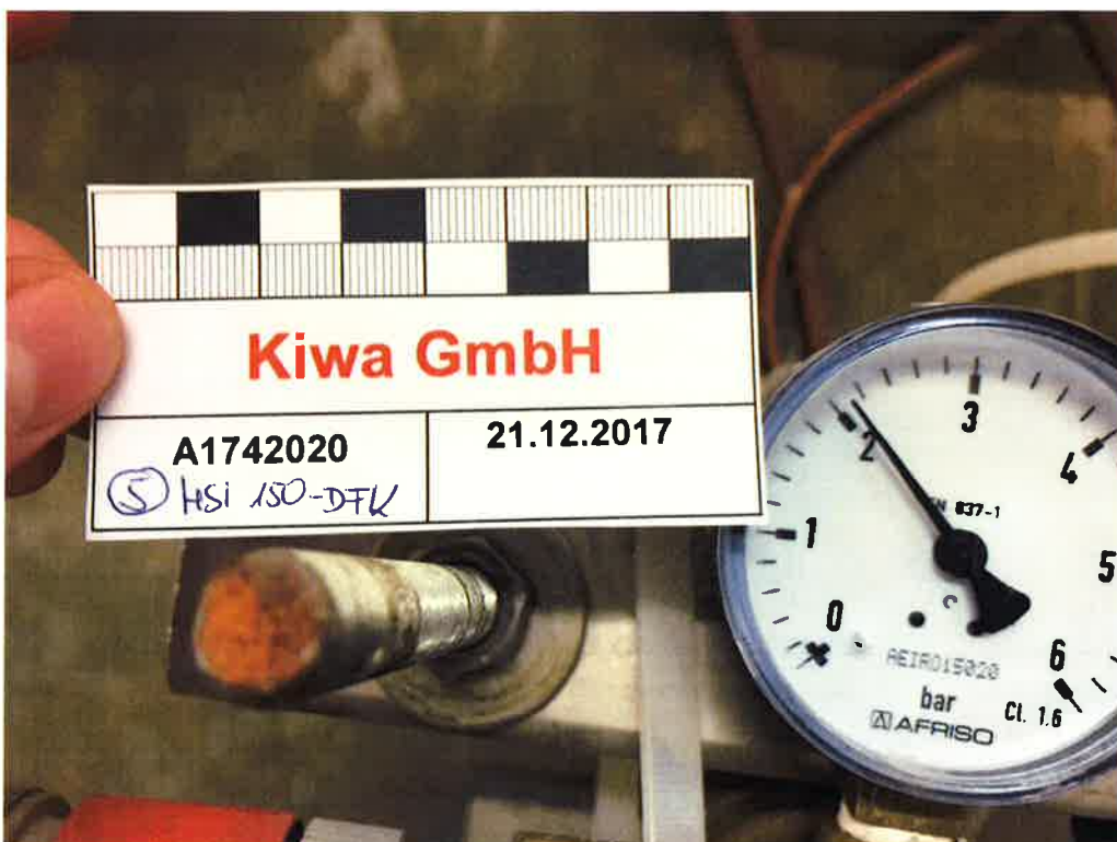
Abbildung A4. Druckdichtigkeitsprüfung der mit wassergefüllten Druckglocke bei einem Nenndruck von \geq 2 bar (Manometerstand nach > 24 Stunden am 21.12.2017).
