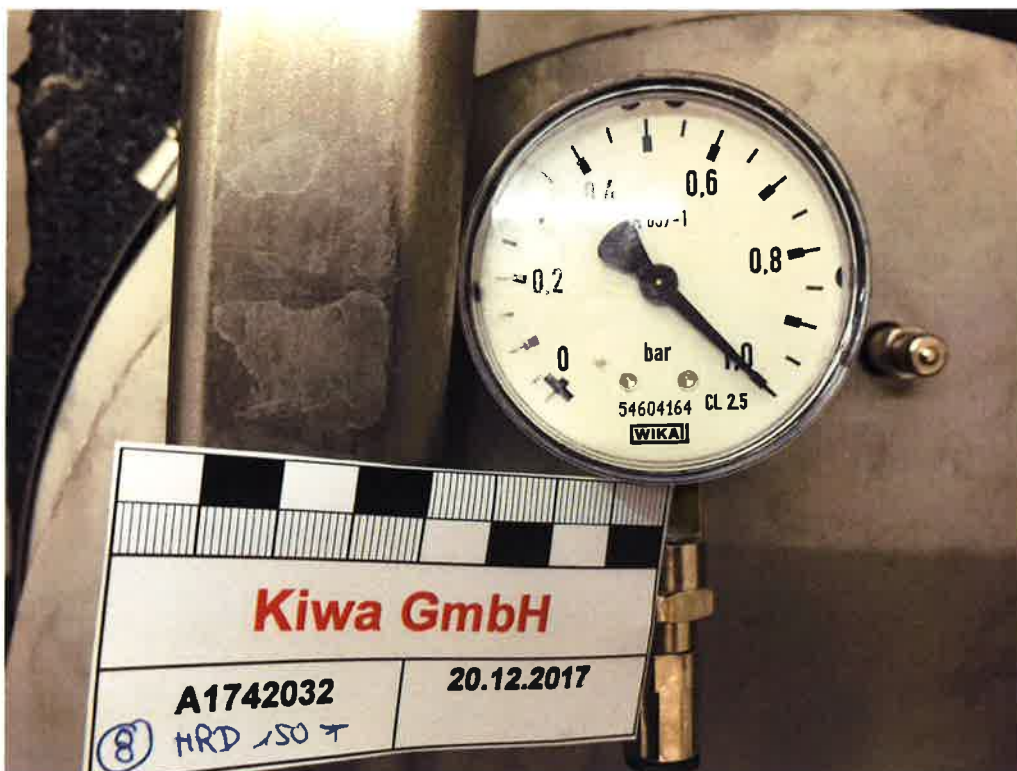
Abbildung A1. Druckdichtigkeitsprüfung der mit wassergefüllten Druckglocke bei einem Nenndruck von \geq 1 bar (Manometerstand bei Versuchsbeginn am 20.12.2017).
