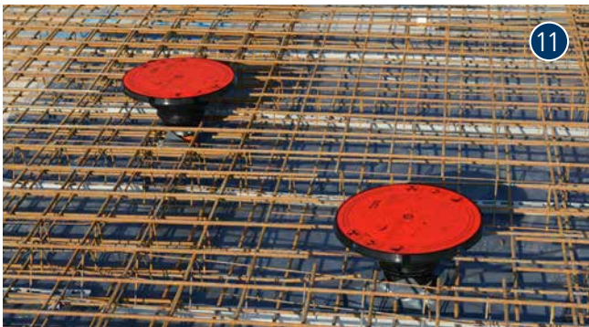
AT110 avant le bétonnage
