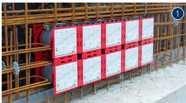
montage du passage double face HSI150 K2 avant le bétonnage
